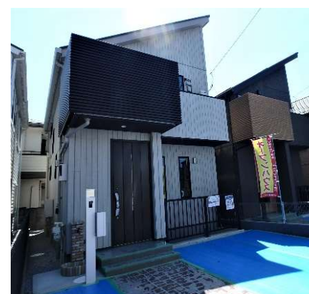
【地下室付建売住宅】
